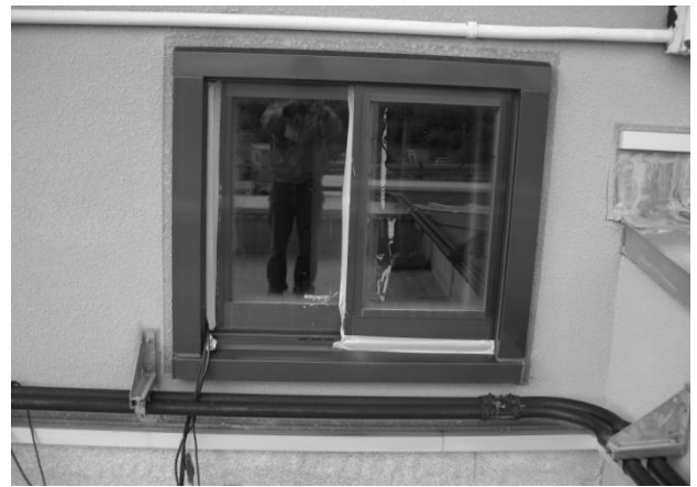
図12 室内への引き込み
