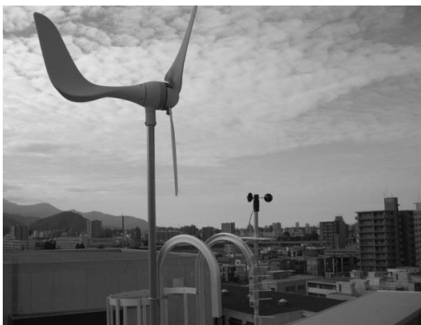
図 15 風力計の設置
