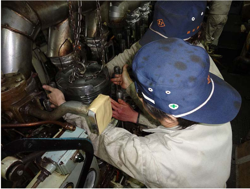
図 6-3 船舶用ディーゼル機関整備・据付
