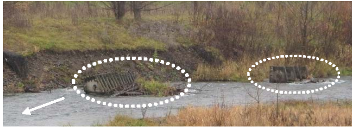
写真 3-2 滞筋の洗掘による木工沈床の崩落（忠別川）
