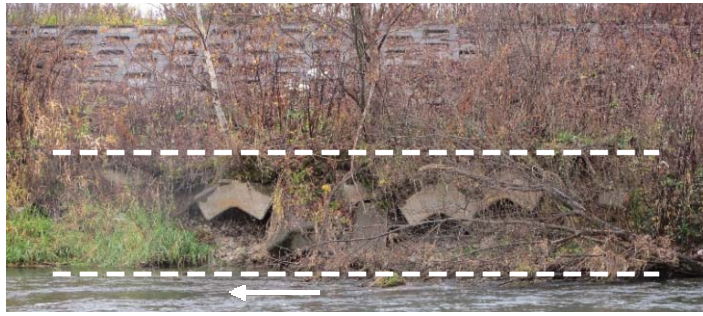
写真 3-1 滞筋の洗掘による根固めの浮き上がり（忠別川）
