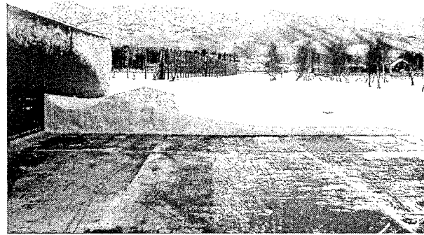
写真2.8 下段屋根上の積雪断面 (2000年1月12日)
