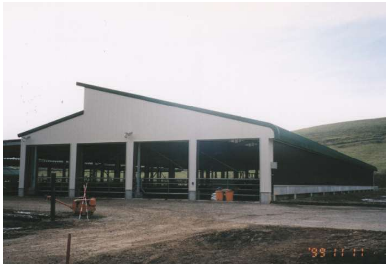
写真-6-4 調査地点3 畜舎
