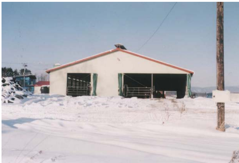
写真-6-3 調査地点 2 畜舎
