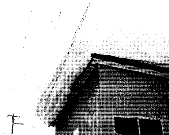
写真 1 - 1 電線にかかった雪庇
