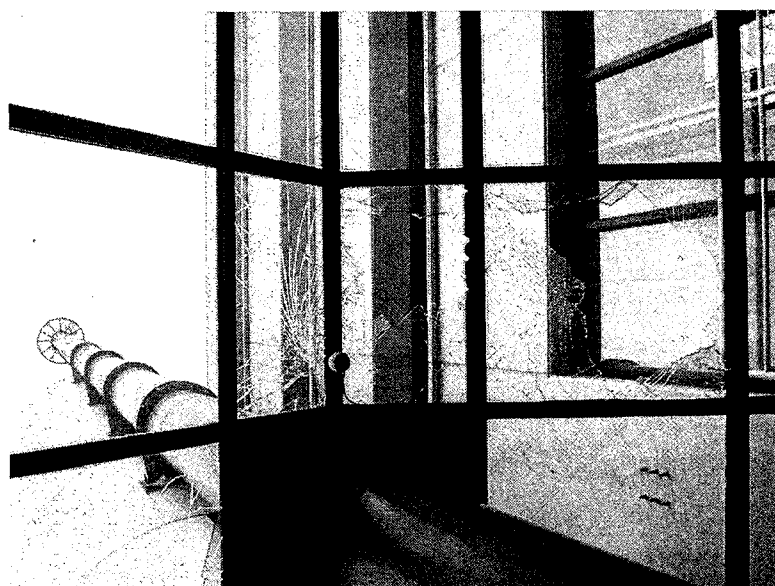
写真1-7 雪氷塊の落下衝突により破損したガラス
