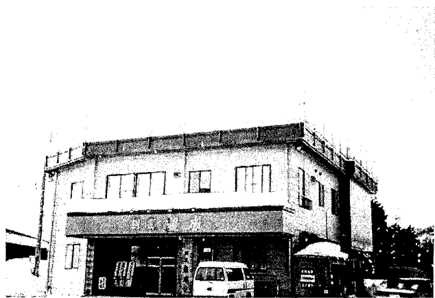
写真 1 - 2 雪庇防止ネット
