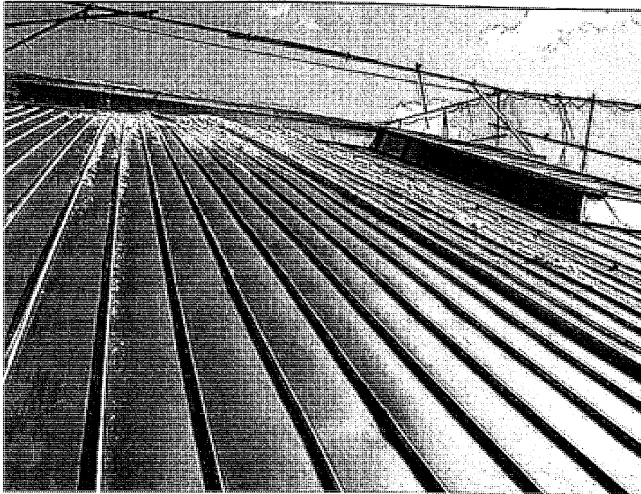
写真 3 - 3 シーム溶接屋根の状況
