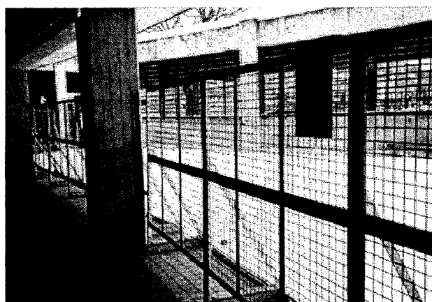
写真 1 - 10 落雪飛散防止柵
