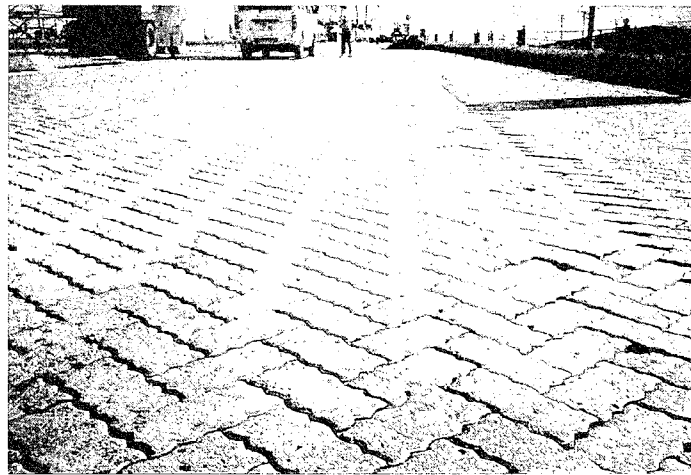
写真 8.1 わだち掘れの状況
