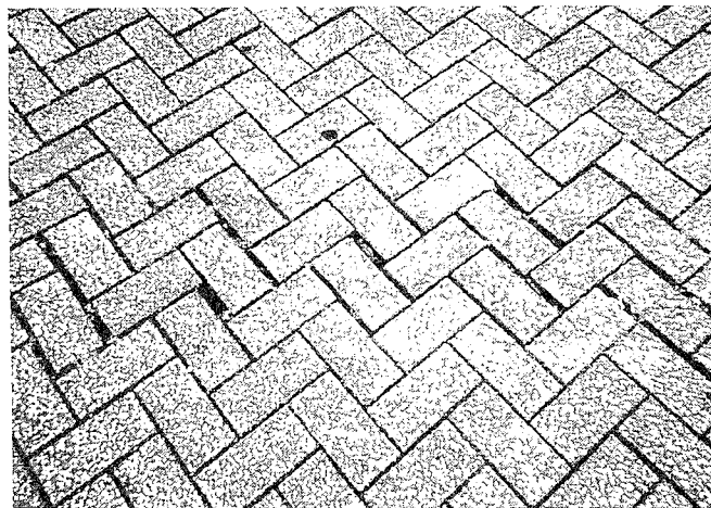
写真 8.4 ブロックの移動現象
