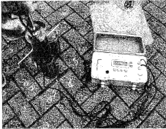
写真 8.5 たわみの測定状況
