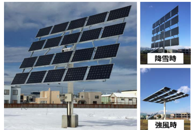
図7 追尾式両面太陽光発電システム
