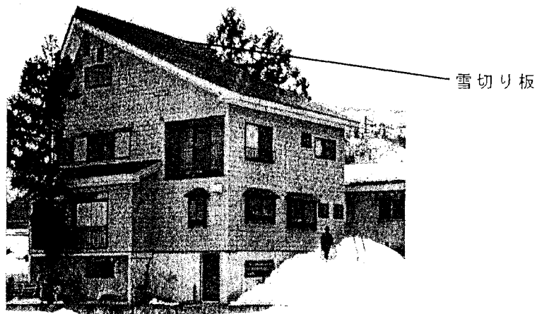
写真3-3 雪切り板が設置された場合の屋根上積雪状況（新潟県塩沢町）
