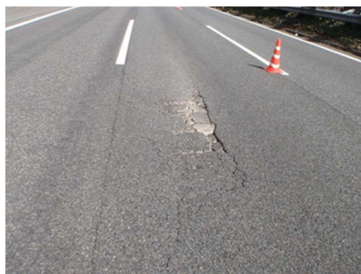
写真-1.2 路盤の損傷状況
