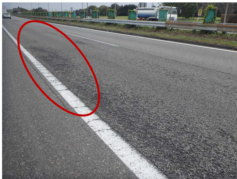
写真-4.5 骨材飛散の状況
