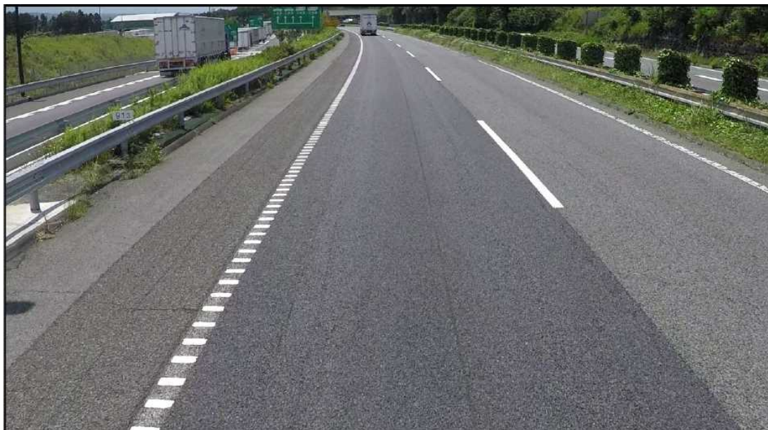
写真-4.3 流動わだち掘れ
