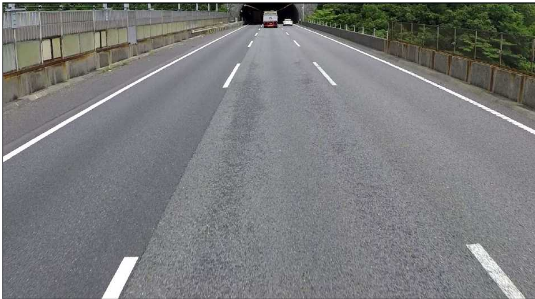
写真-4.2 骨材飛散によるわだち掘れ
