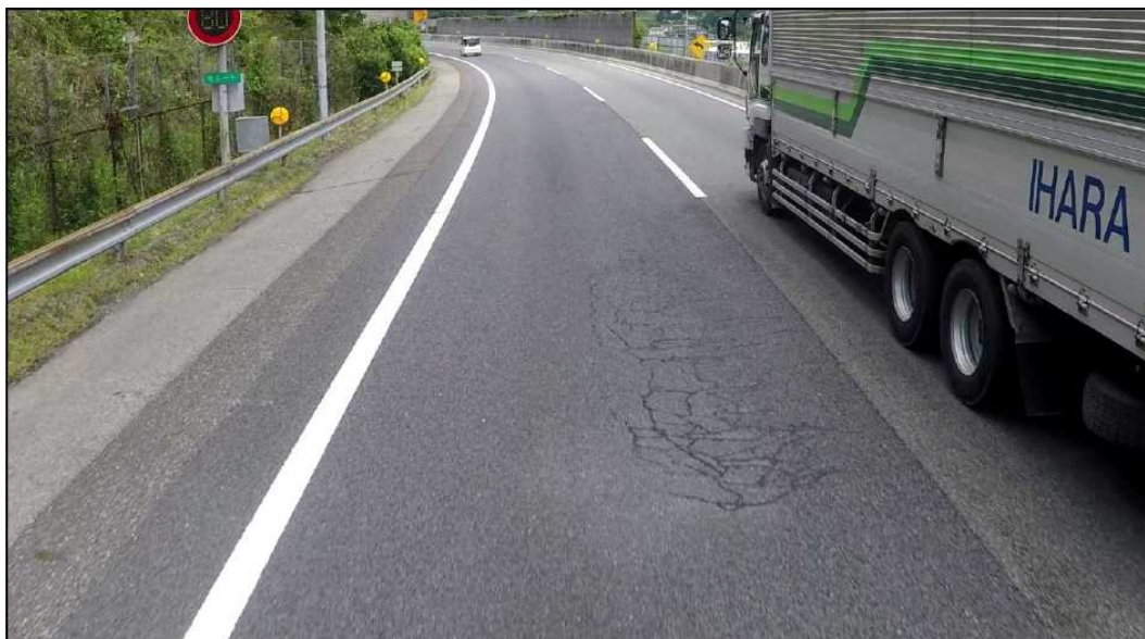
写真-4.1 局部変形・くぼみ
