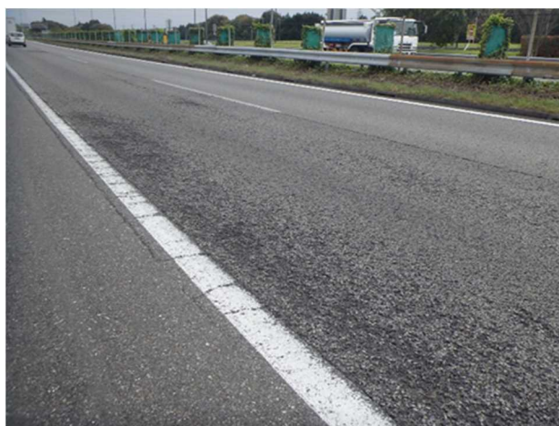
写真-1.3 骨材飛散状況
