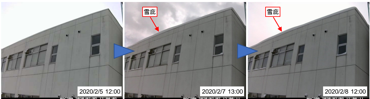
写真 3 8号館 2 階屋上における北東側軒先の雪庇形成状況
