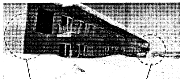
C避難口側より全景
