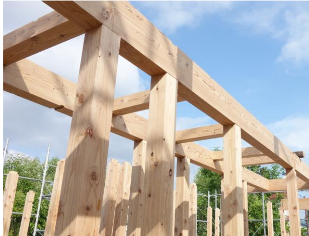
図 4-5 コアドライ材を使用した住宅の構造材
