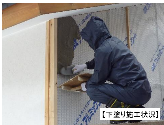
写真 3.6 試験施工の対象とした木造住宅および下塗り施工状況
