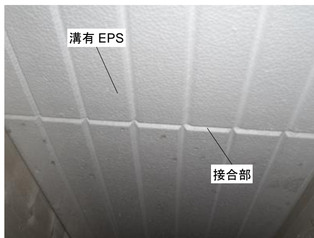
写真 4.7 溝有 EPS の接合状況
