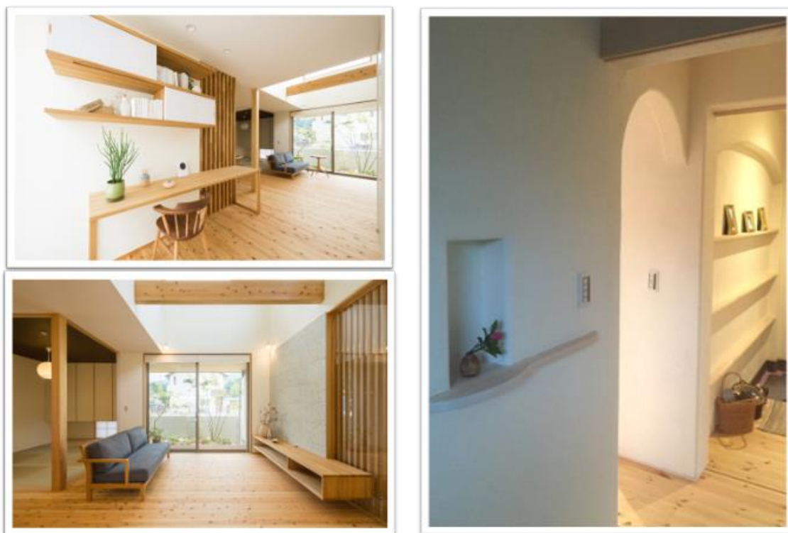
写真 7.1 ホタテ貝殻粉末を用いた内装塗り壁材の施工事例
