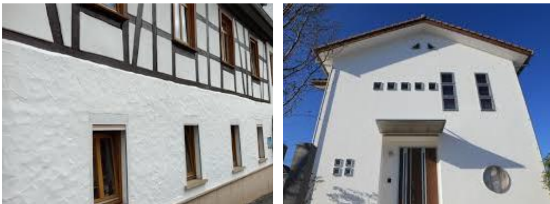
写真 1.2 漆喰壁の施工事例
