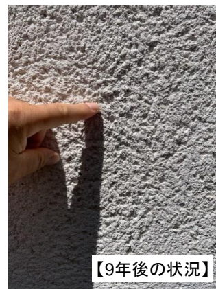
写真 3.10 9 年後の外装劣化状況
