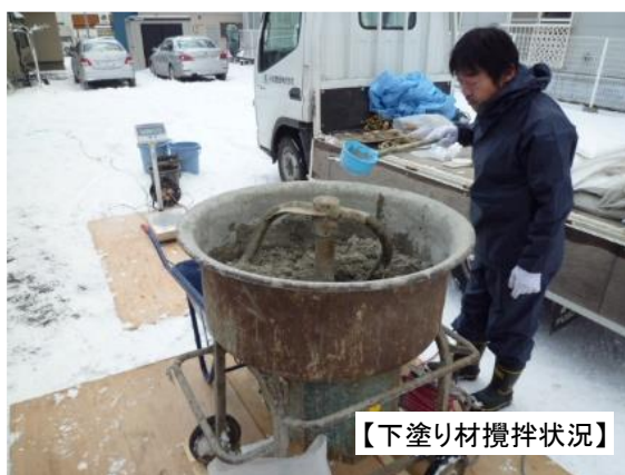
写真 3.6 試験施工の対象とした木造住宅および下塗り施工状況
