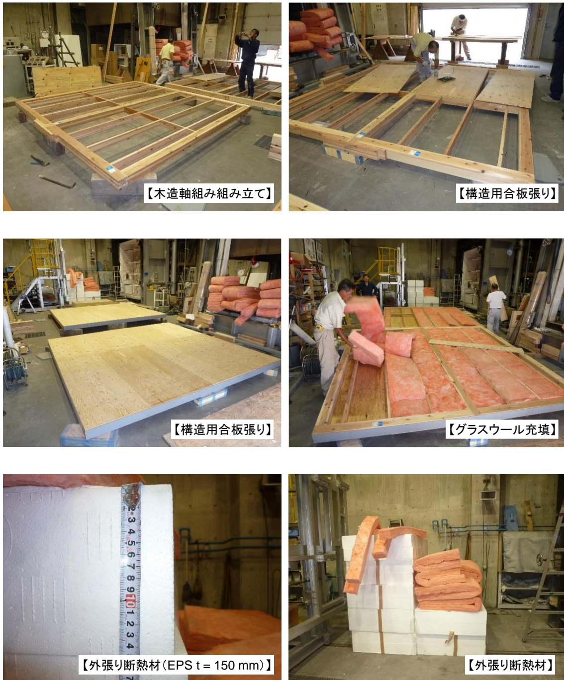
写真 6.2 試験体の作製状況
