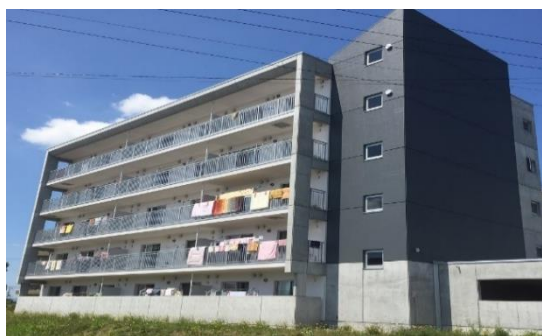
岩見沢市営住宅日の出団地
