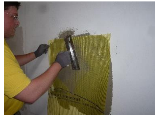
写真 4.2 下塗り(Base Coat)およびガラス繊維メッシュ施工指導
