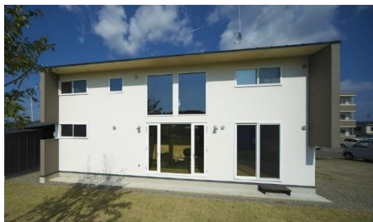
青森県八戸高専実証住宅
