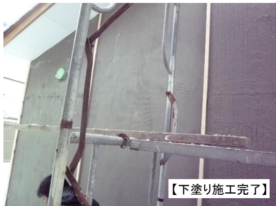
写真 3.7 下塗り施工状況
