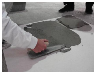
【水平面試験塗り】
