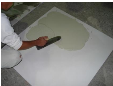
【水平面試験塗り】
