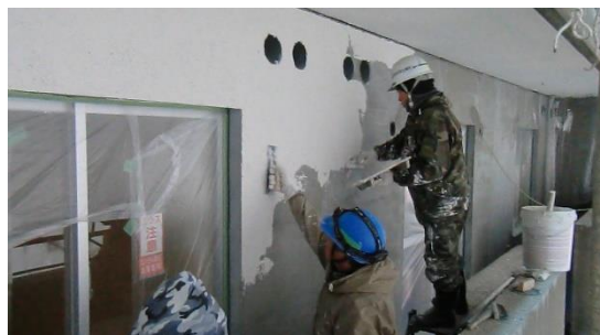
バルコニー側外壁施工例
