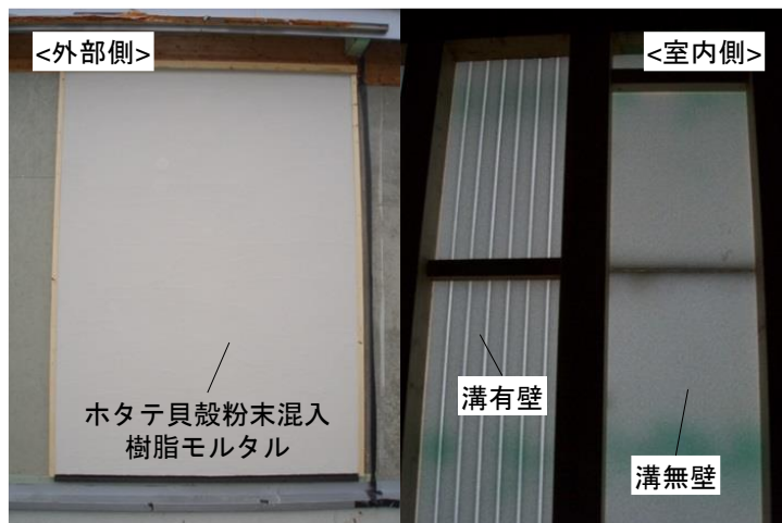
写真 4.6 内外部試験壁
