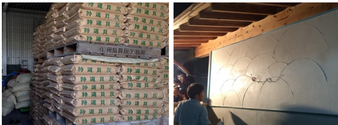
写真 1.4 製造された貝灰およびホタテ貝殻粉末入り内装材の施工状況
