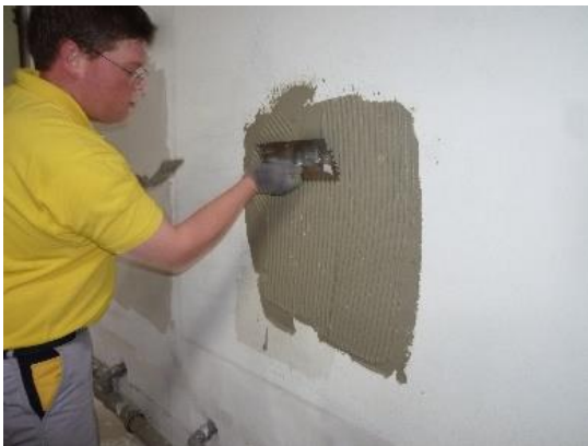
写真 4.2 下塗り(Base Coat)およびガラス繊維メッシュ施工指導
