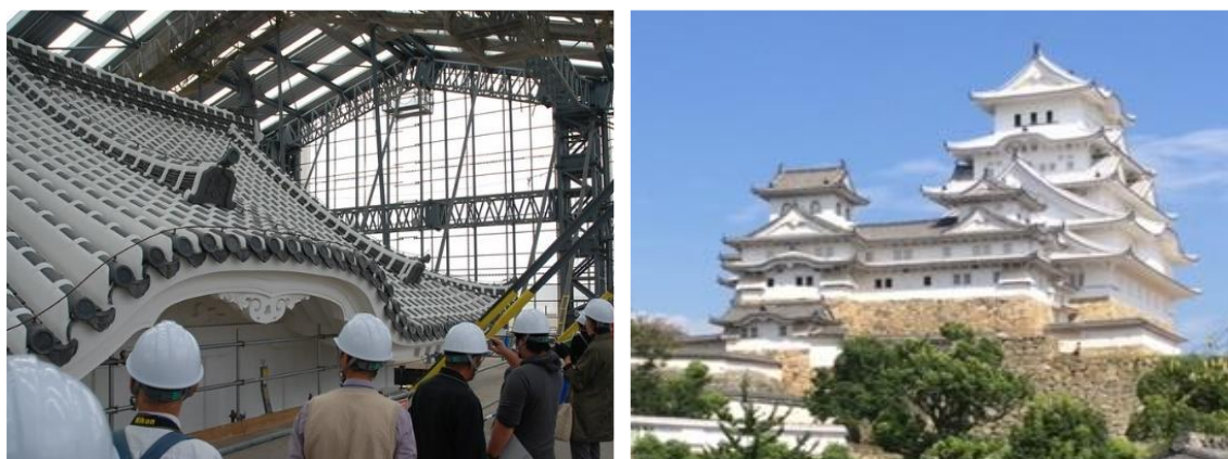
写真 1.3 姫路城における平成の大改修
