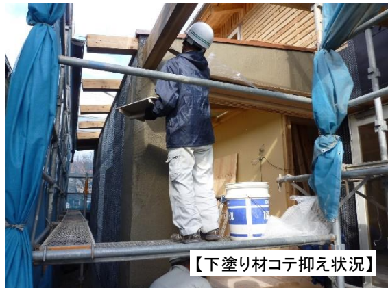
写真 3.4 シラスを主原料とした外壁材施工のヒアリング調査の状況(2)
