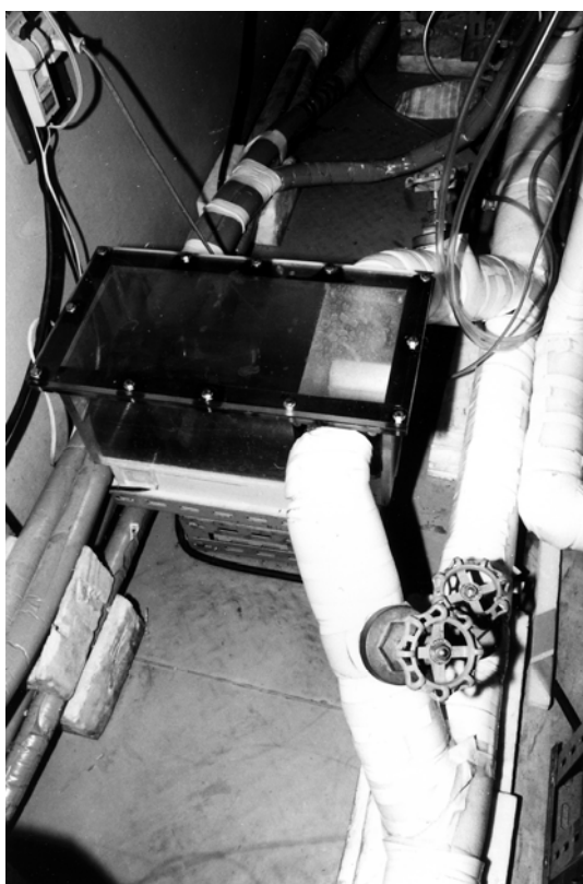
図3. 27 加湿器および配管
