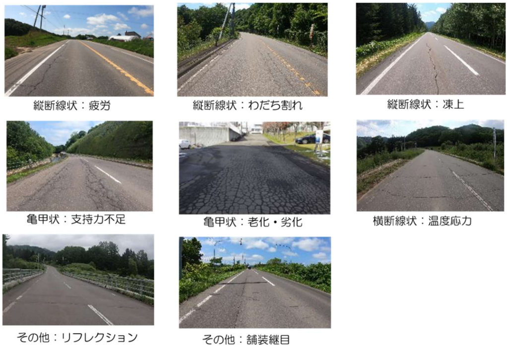
図-4-2 ひび割れ形状と発生原因の例
