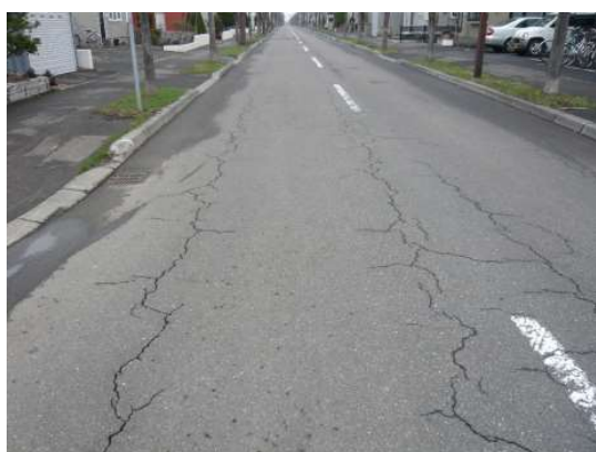
写真-1.1 舗装の損傷例 （左：ひび割れ 右：わだち掘れ）
