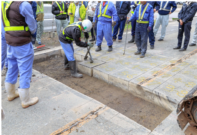
写真-1.12 舗装版の吊り上げ状況
