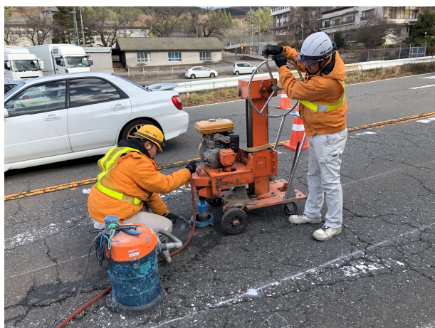
写真-1.5 削孔機によるコア採取状況
