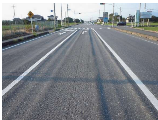
写真-1.1 舗装の損傷例 （左：ひび割れ 右：わだち掘れ）
