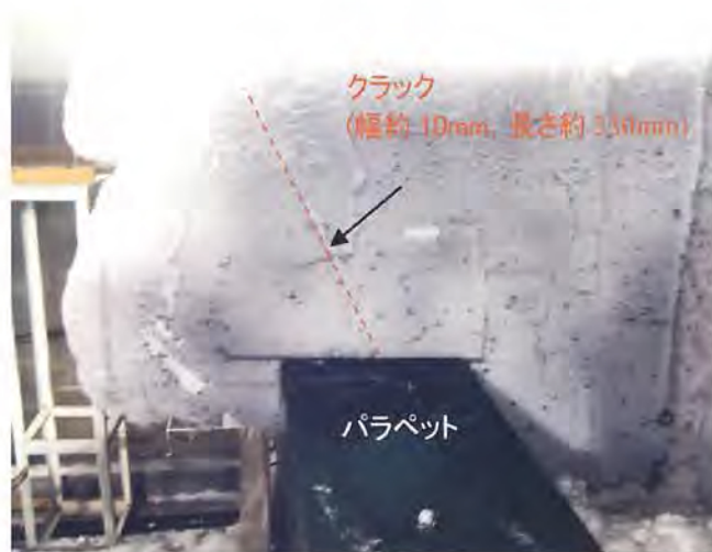
写真 4-2-8 雪庇の断面
