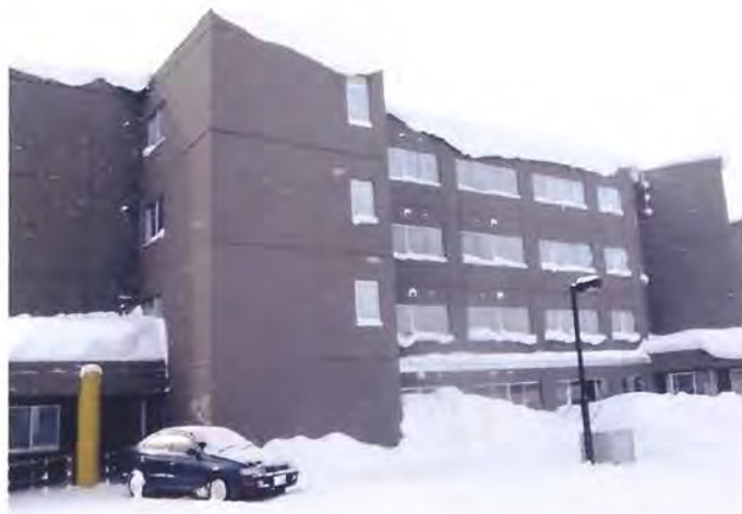
写真 2-8 屋根上の雪庇(滝川市)
