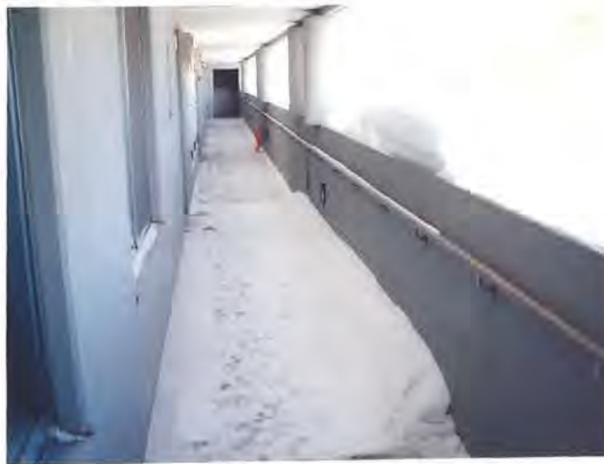
写真 2-5 通路(開放型片廊下)への雪の吹き込み(小樽市)
