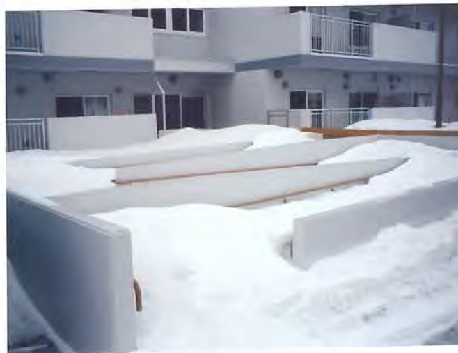
写真 2-2 積雪により使用ができない歩行用スロープ(恵庭市)
