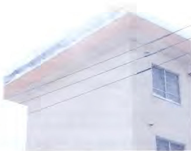
写真 4-1-2 雪庇防止柵の設置例(旭川市)
