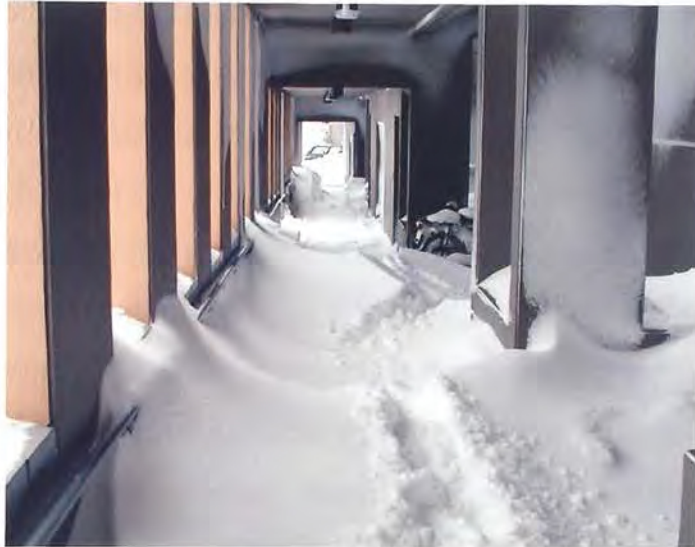
写真 3-2-3 Case07 における通路内への雪の吹き込み
